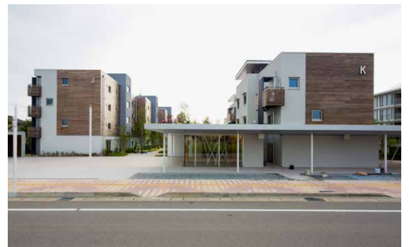
バッシブタウン第3期街区)棟/K棟 (富山県黒部市) 設計: 森みわ リノベーションによるバッシブハウス
